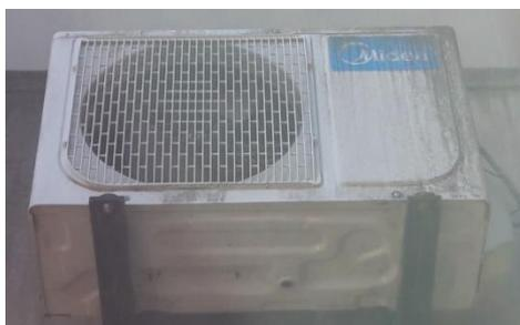
FOTO 02: Máquina condensadora
