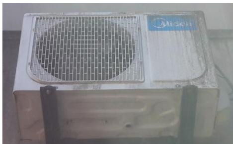
**FOTO 02:** Máquina condensadora
