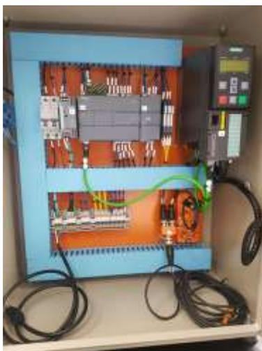
**Resposta à Pergunta 10:** *Confecção de Suportes Mecânicos para fixação do painel SAEP na nova bancada. Confecção de furação de prensa cabos para saída dos cabos dos sensores da nova bancada. Interligação da bancada ao painel existente.*
